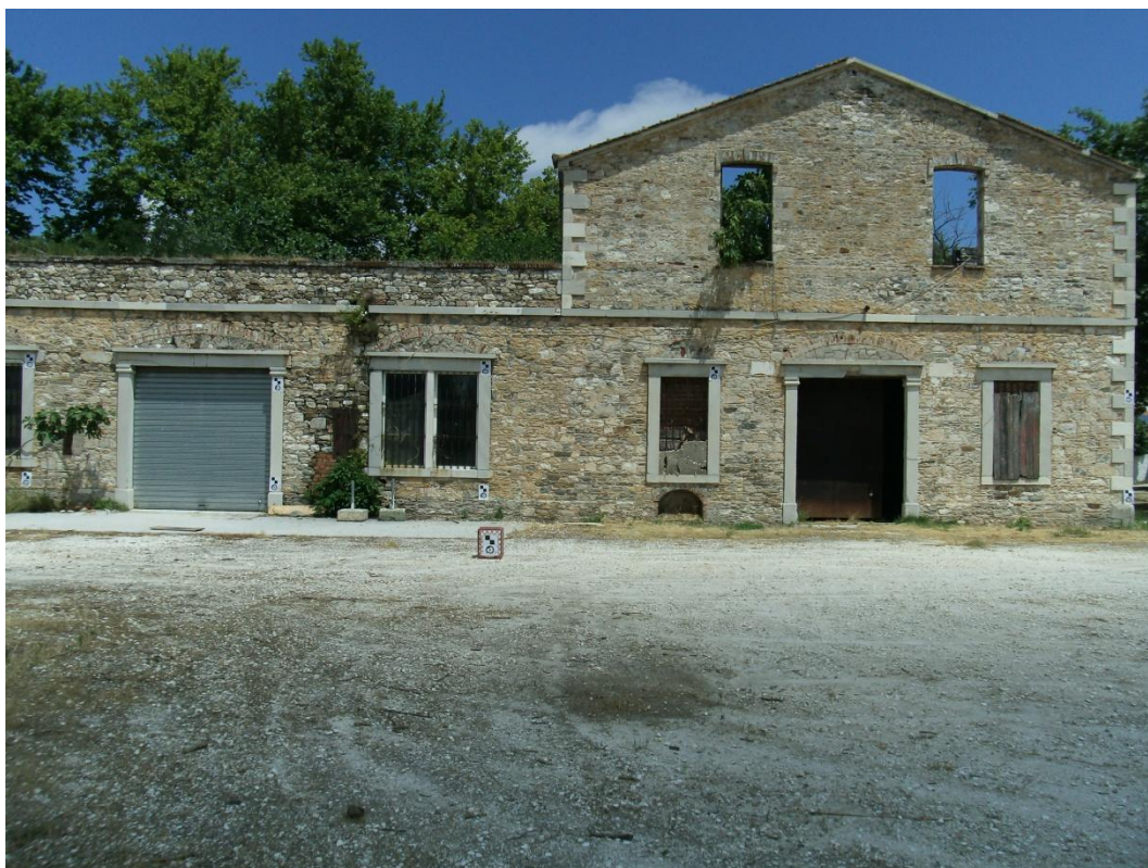
Fig. 9. Fațada clădirii studiate
