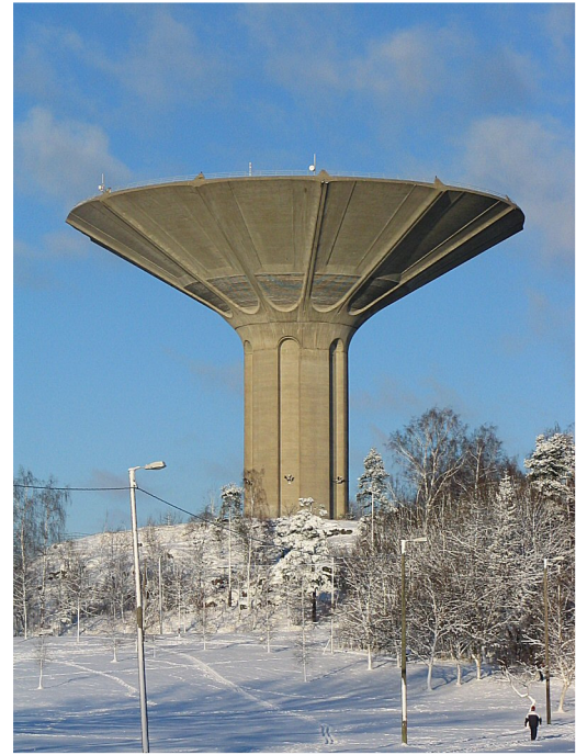
Figura 8.2. Tipuri de structuri: sisteme flexibile la torsiune (a), sisteme de tip pendul inversat (b), exemplu – un castel de apă din b.a. ( http://en.wikipedia.org/wiki/Water_tower ).
