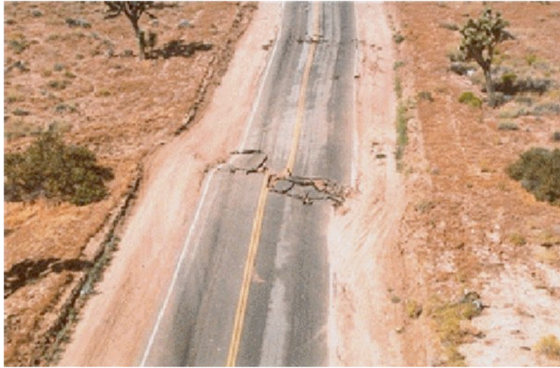
Figura 3.7. Efectul unei falii transcurrente la suprafața terenului (USGS, n.d.)
