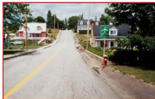
Instalație de drenare periculoasă pe un drum îngust în pantă.
