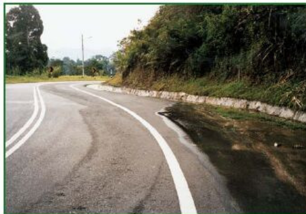
Acostament consolidat cu structură de drenaj în pantă
