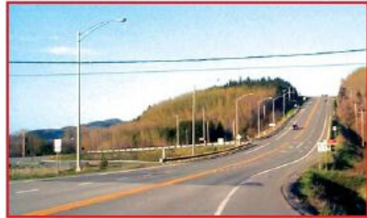
Se evită combinarea unei intersecții cu banda pentru vehicule lente
