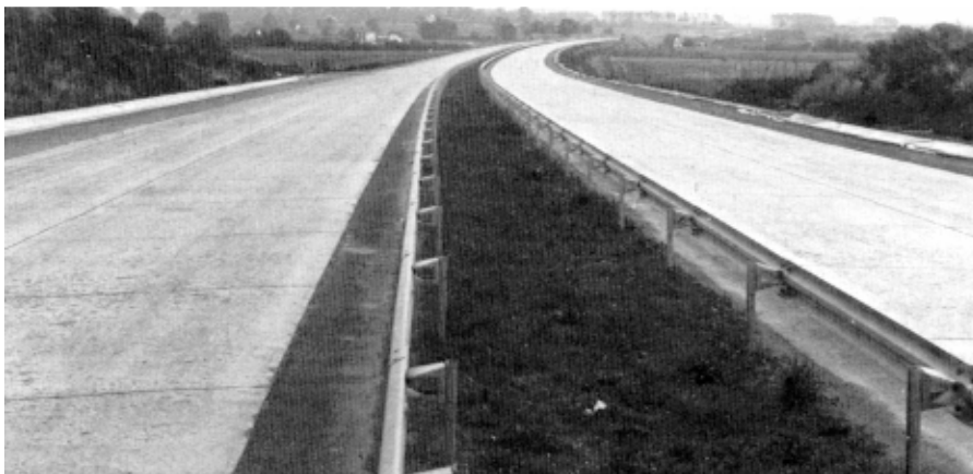
Fig. 2. Drum cu îmbrăcămintă din beton de ciment.
