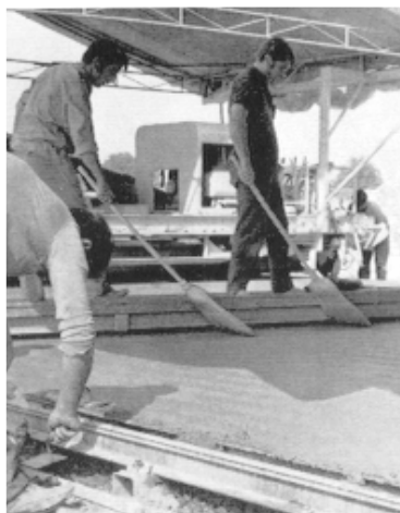
Fig. 50. Executarea operațiilor de finisare manuală a suprafeței de rulare.
