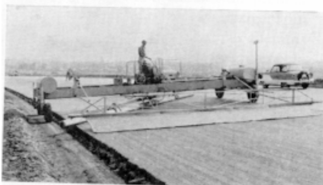
Fig. 51. Asigurarea rugozității suprafeței betonului proaspăt cu ajutorul pânzei de iută.
