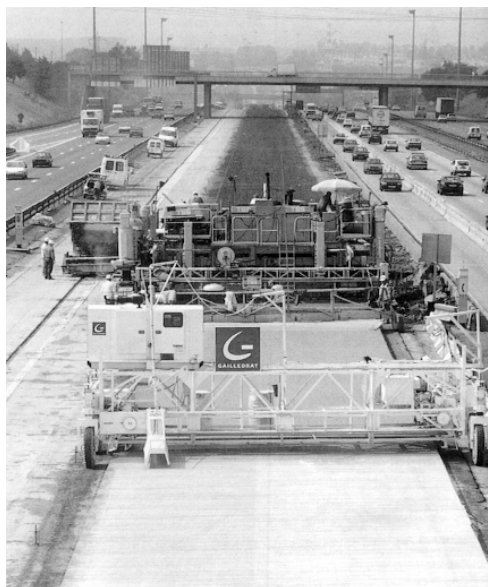
Fig. 38. Realizarea îmbrăcăminților din beton de ciment pe calea unidirecțională a unei autostrăzi.
