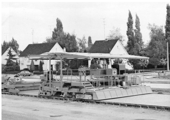
Fig. 46. Placă suspendată pentru finisarea îmbrăcămintei rutiere.
