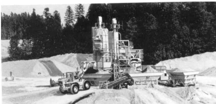
Fig. 36. Centrală de mare productivitate pentru prepararea betoanelor.
