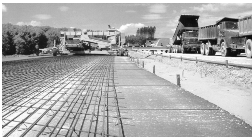
Fig. 69. Realizarea îmbrăcămînților din beton de ciment armate continuu cu ajutorul mașinilor cu cofraje glisante.
