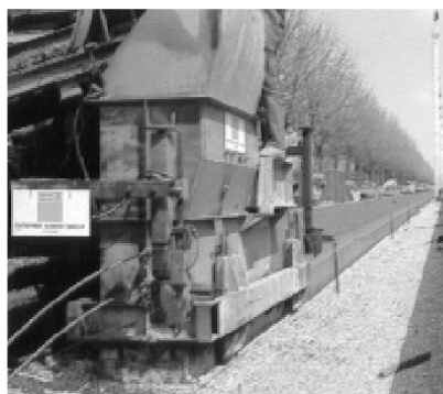
Fig. 47. Ghidarea mașinii cu cofraje glisante, folosind palpatorii tip "furculiță".
