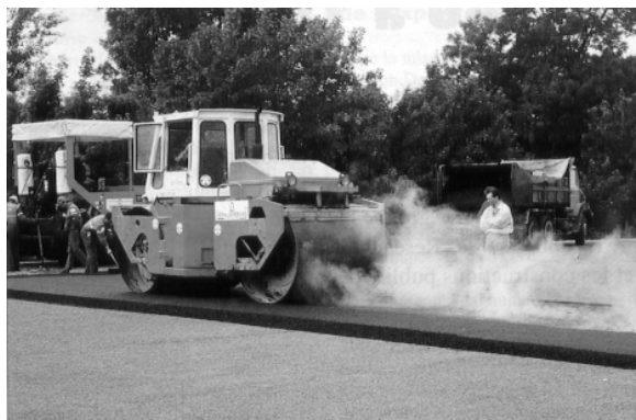
Fig. 26. Compactor cu rulouri netede.
