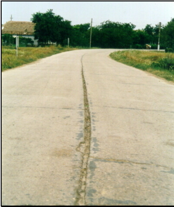
Fig. 3.5. Deschiderea rosturilor longitudinale
