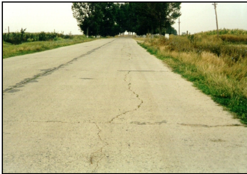
Fig. 3.9. Fisuri longitudinale
