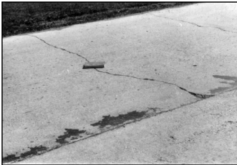
Fig. 3.8. Fisuri transversale
