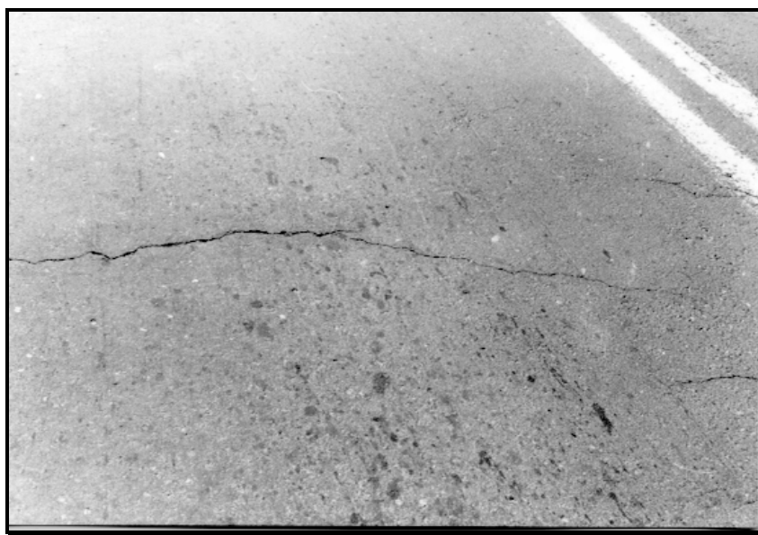
Fig. 2.11. Fisuri transversale
