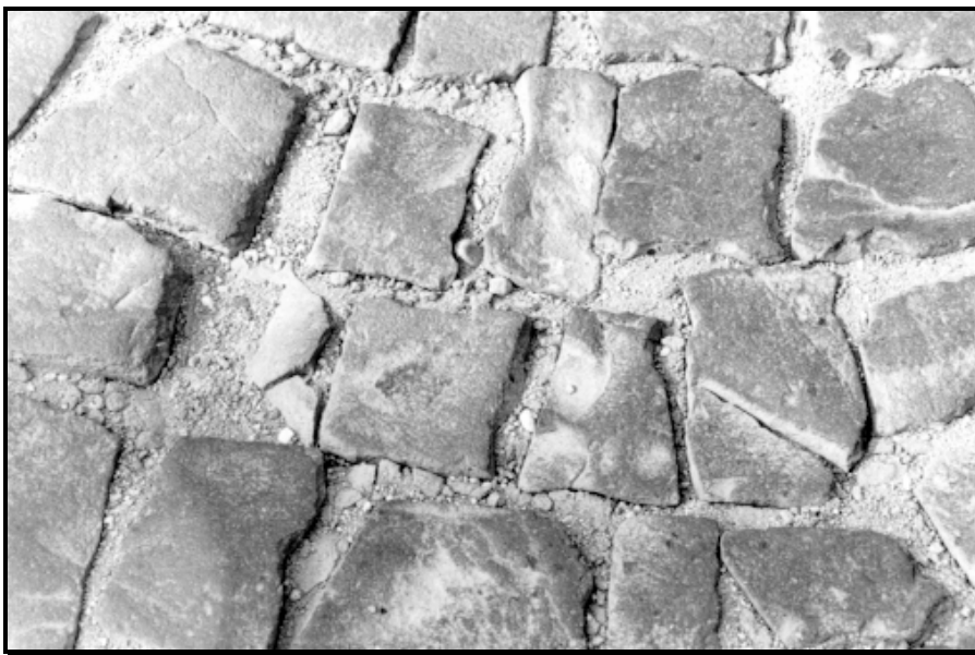
Fig. 4.2. Pavele sparte și înfundate
