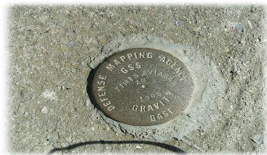
Fig. 3.7: Marca punctului de ordinul II AVIASAN (stânga), secțiune printr-o marcă (Rețeaua gravimetrică a Republicii Moldova)
