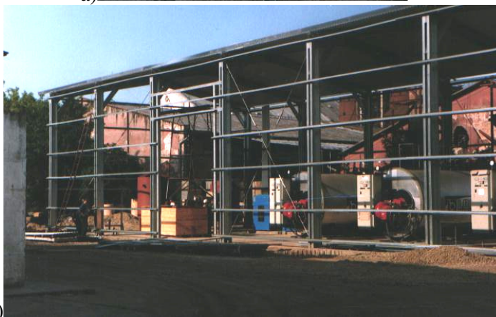
Fig. 18: Profile Z și C utilizate pentru: a) pane de acoperiș (ALCATEL-DATATIM, Timișoara) și b) rigle de perete (ARBEMA, Arad)
