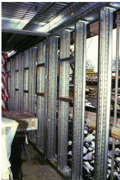
Fig. 23: Panouri prefabricate realizate cu profile C perforate în vederea ruperii punții termice
