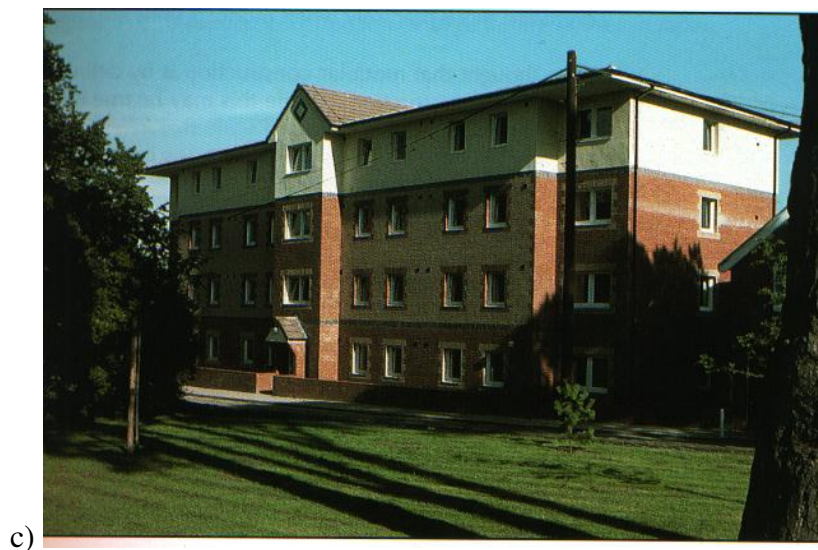
Fig. 33: Unități modulare prefabricate utilizate pentru un cămin studențesc la Universitatea din Walles, Cardiff (Lawson, 1999) (a) Unitate modulară prefabricată; (b) Clădirea în timpul execuției; (c) Clădirea finisată.
