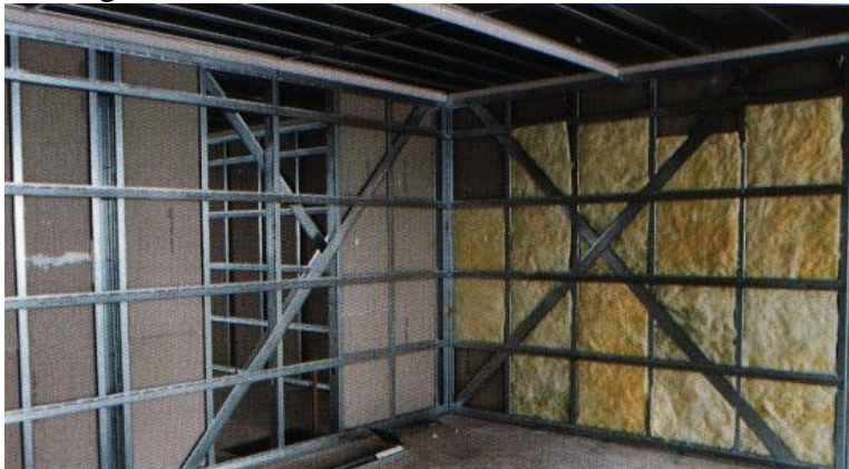
Fig. 20: Perete despărțitor în interiorul unei clădiri
