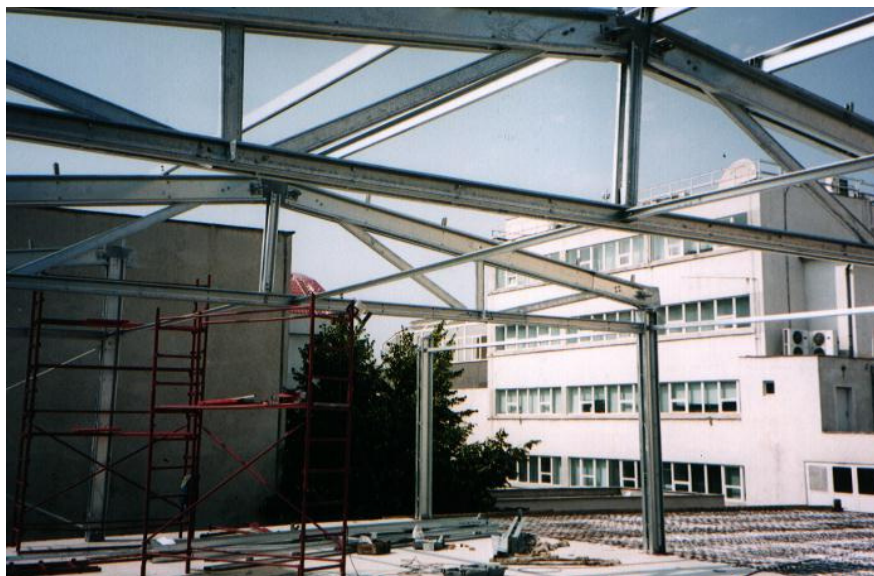
Fig. 28: Ferme realizate din profile cu secțiune compusă din profile C de tip LINDAB, îmbinate cu șuruburi, pentru o supraetajare (ALCATEL, Timișoara)
