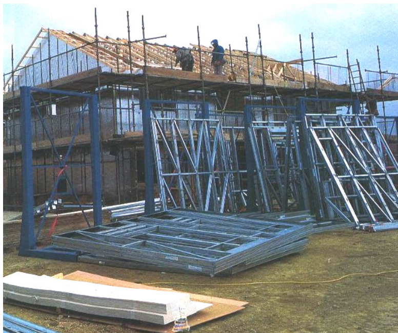
Fig. 21: Sistem de panouri prefabricate pentru pereți și acoperiș din lemn
