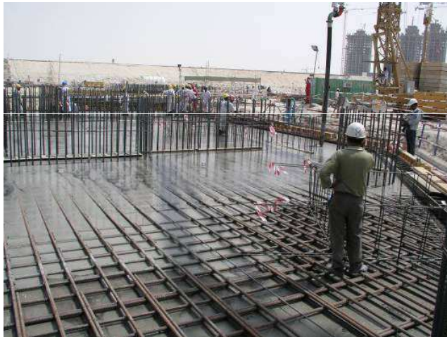
Turnarea fundației tip radier general
