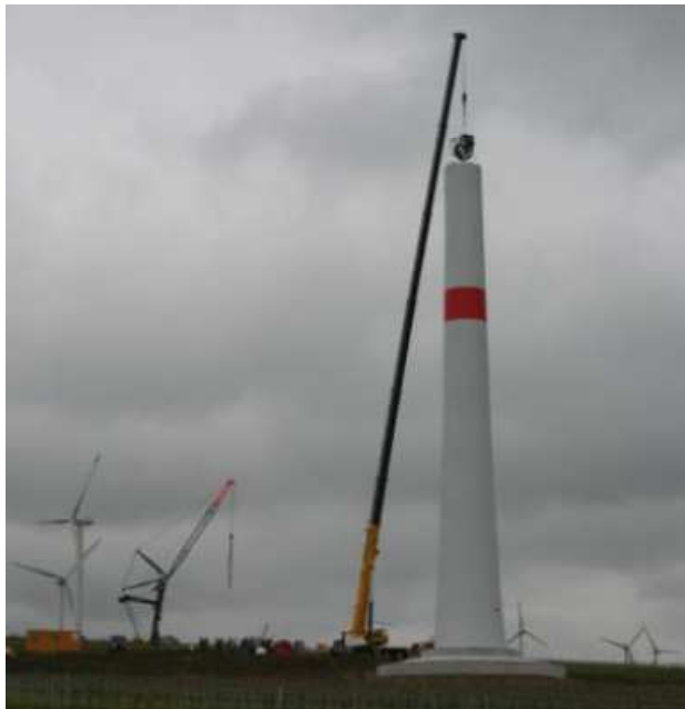
Turn eolian – structură din beton precomprimat prin postîntindere
