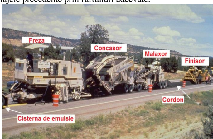
Fig. 2.13. Atelier de reciclare la rece cu lianți bituminoși.
