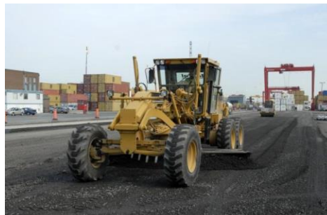
Fig. 2.10. Nivelarea stratului reciclat.
