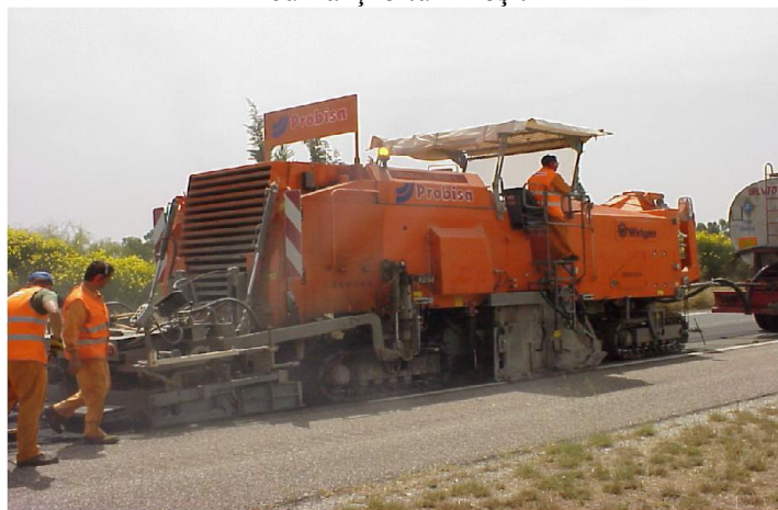
Fig. 2.12. Utilaj care asigură frezarea, omogenizarea și punerea în operă.
