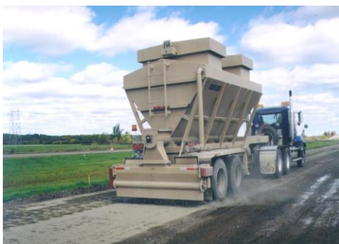
Fig. 2.5. Răspândirea cimentului în pulbere.
