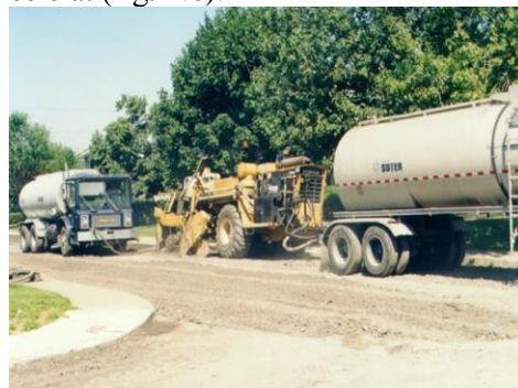
Fig. 2.6. Răspândirea liantului în soluție apoasă.
