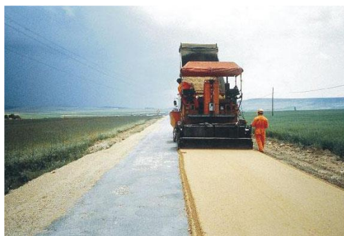
Fig. 2.4. Aport de agregat natural pentru creșterea grosimii stratului reciclat.
