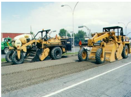
Fig. 2.3. Frezarea straturilor asupra cărora se va realiza reciclarea.
