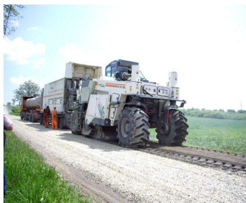
Fig. 2.18. Utilaj care asigură frezarea și omogenizarea, cu așternere în strat.
