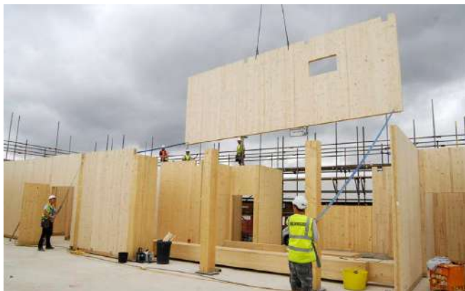
Figura 2. Montarea unui perete de CLT[5]
