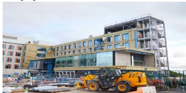
Figura 11. Aplicarea vatei bazaltice pe pereții Spitalului Grange University [11].
