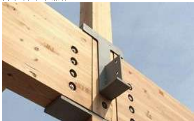
Figura 7. Fixarea grinzilor din CLT[3]
