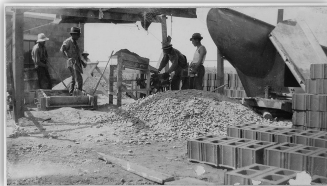
Figura 2. Muncitori realizând blocuri din beton [4]
