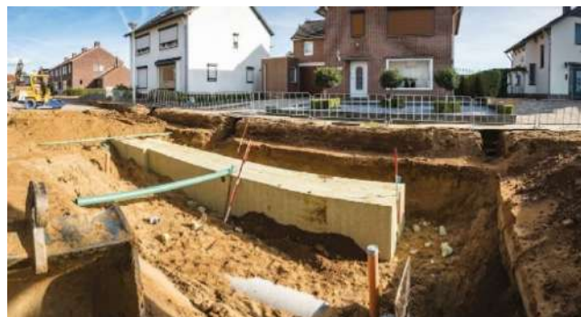
Figura 8. Renovarea sistemului de canalizare în satul Maasbracht din Olanda[8].
