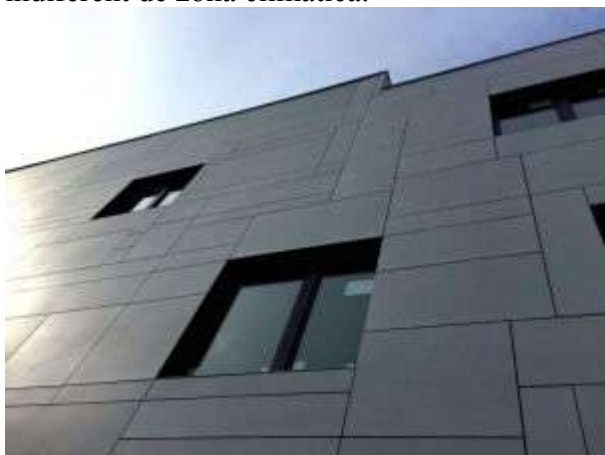
Figura 2. Fațadă exterioară placată cu plăci de fibrociment [7]
