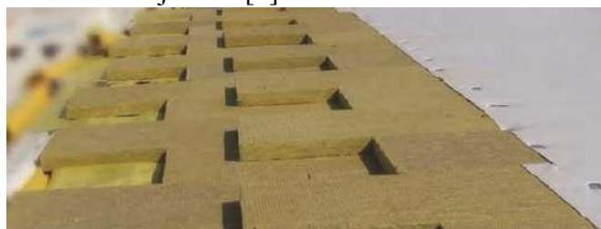
Figura 2 . Termoizolație terasă necirculabilă cu vată minerală bazaltică [2].
