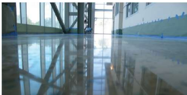
Figura 1. Șapa autonivelantă după aplicare. [9]
