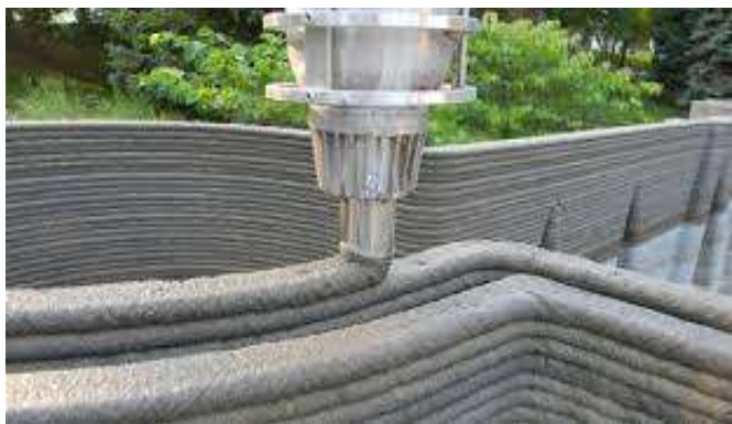
Figura 8-Turnarea betonului prin imprimare [6]
