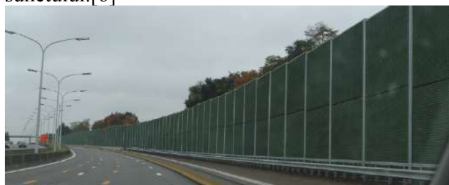
Figura 7. Bariere acustice instalate pe autostrăzi.[6]
