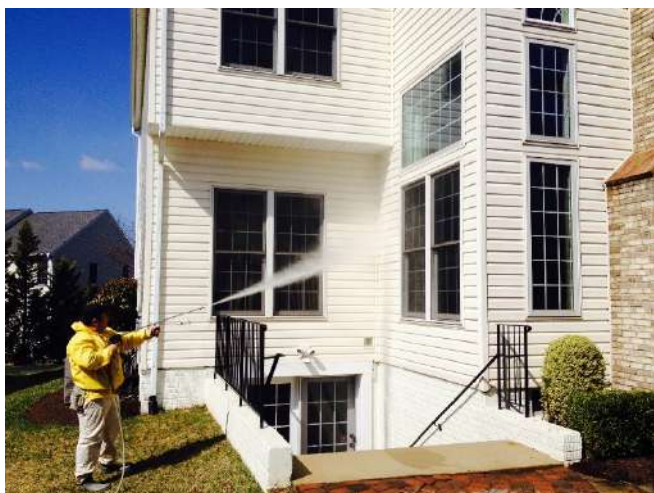
Figura 6. Curățarea unei plăci din fibrociment după aplicarea unei soluții [11]
