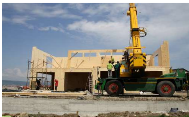
Figura 19. Șantier EvoHouse, Cluj, România [18]
