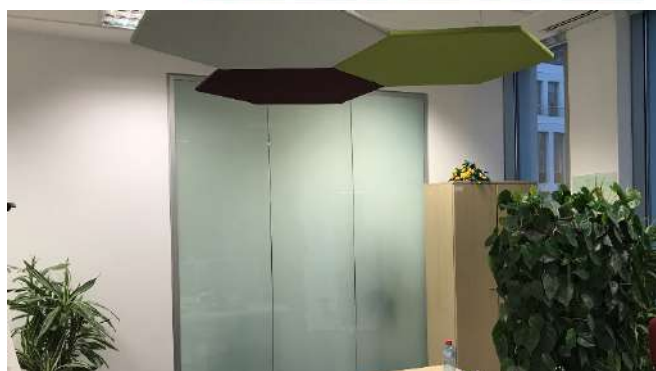
Figura 8. Sticlă cu cristale lichide dispersată în polimeri atunci când se aplică electricitate pe sticlă. [7]
