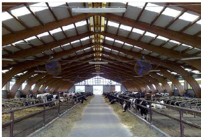
Figura 2 Ferma contruita din grinzii lamelare [4]
