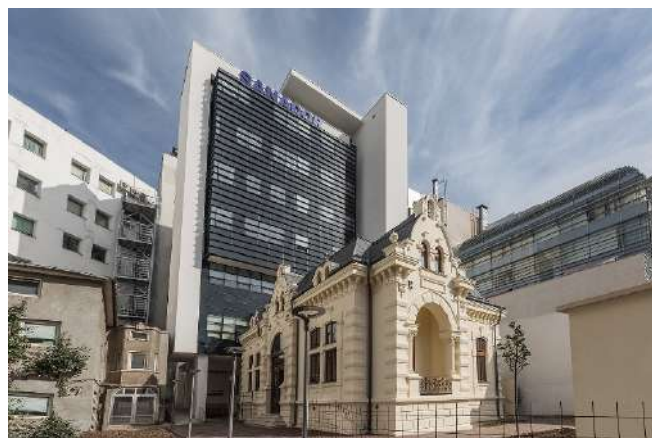
Figura 3. Exalcobond. Placare cu panou compozit în România.[7]
