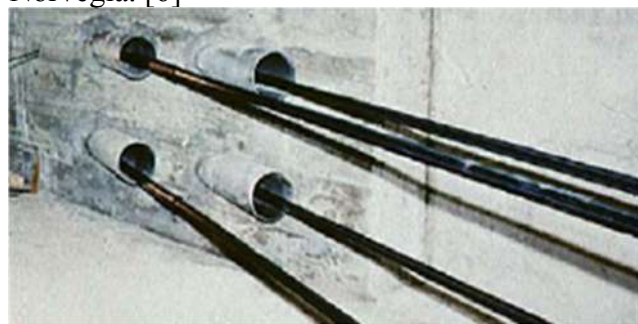
Figura 2 Cabluri CFRP, Elveția [1]
