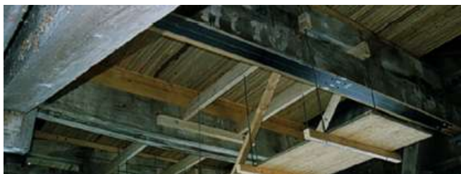
Figura 1 Sins Brigde, consolidare cu CFRP [5]
