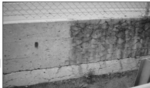
Figura 3. Diferența - (stânga) suprafață tratată cu silan, (dreapta) suprafață netratată cu silan [2]
