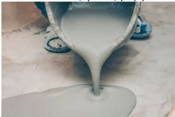
Figura 2. Turnarea șapei autonivelante. [9]
