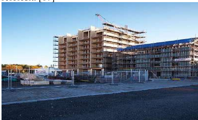
Figura 17. Lucrări din timpul șantierului la Västerås [17]
