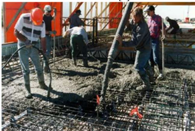
Figura 4 Armătură cu plasa CFRP [1]
