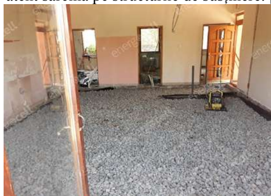
Figura 5. Reabilitare clădiri de locuit [4]
