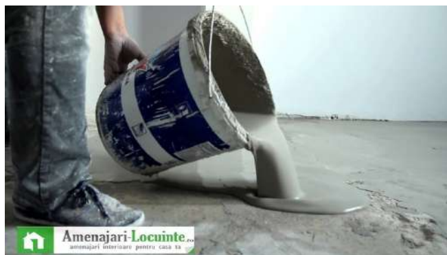
Figura 6. Turnarea șapei autonivelante. [5]
