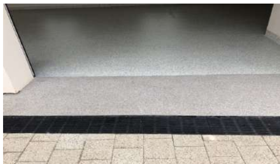
Figura 9. Șapă montată în exterior și interior [13]
