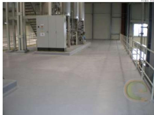
Figura 7. Șapă montată într-o fabrică [11]
