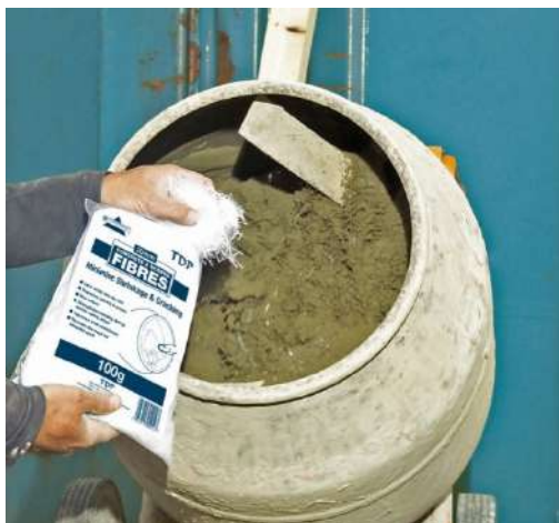
Figura 2. Adăugarea fibrelor de polipropilenă
