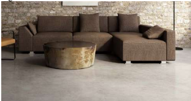
Figura 6. Pardoseală finalizată – microciment
