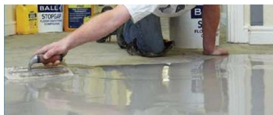
Figura 5. Uniformizare șapă [9]
