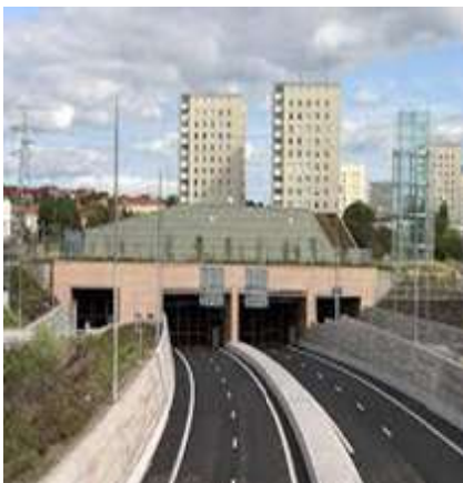
Figura 4. Lucrări de infrastructură din Södra Länkens, Suedia [7]
