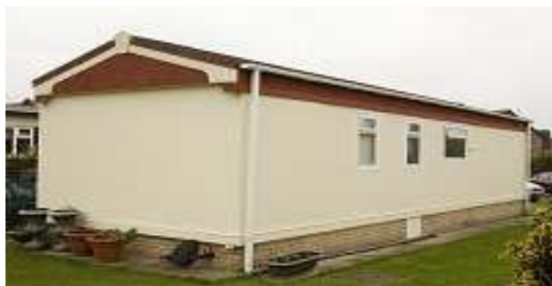
Figura 9. Finalizarea procesului de izolare si finisare [2]
