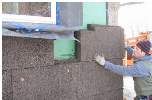
Figura 4. Montare perete exterior cu panou din plută [8]
