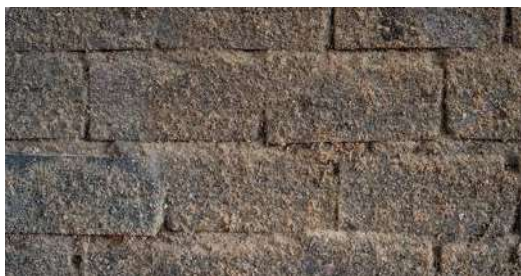
Figura 3 – zid de cărămizi acoperite cu rumeguș [8]
