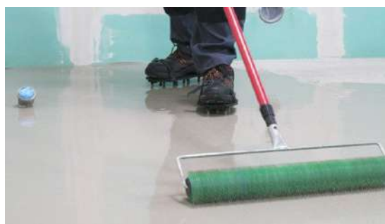
Figura 6. Eliminarea bulelor de aer [9]
