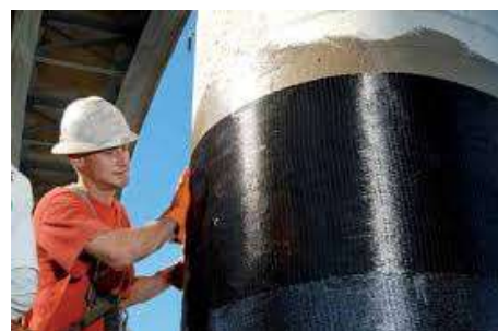
Figura 4. Consolidare cu fibră de carbon [11]
