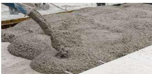
Figura 3. Turnarea betonului cu fibre de polipropilenă
