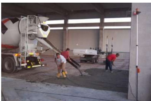
Figura 6. Turnare pardoseală industrială
