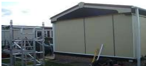
Figura 8. Apropierea de final a procesului izolare [2]
