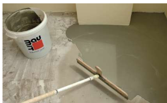
Figura 4. Uniformizare șapă [9]
