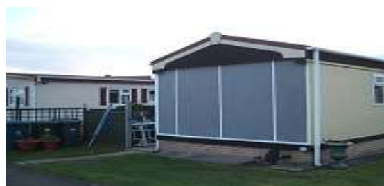
Figura 7. Avansarea procesului de izolare [2]
