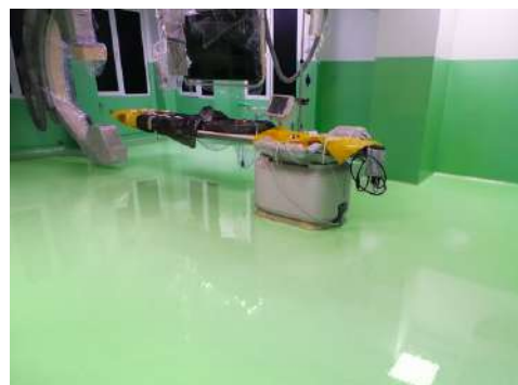
Figura 8. Șapă montată într-un spital [12]
