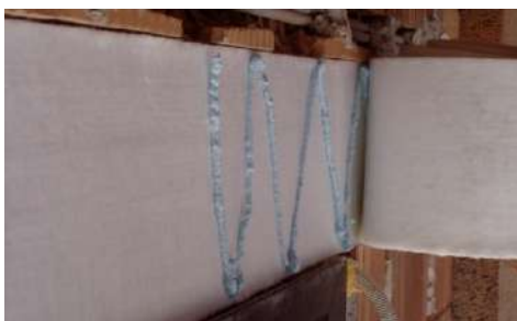
Figura 11. Utilizarea rolelor din aerogel în izolarea zidărilor [3]
