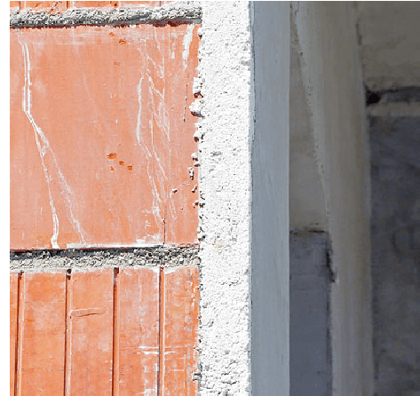
Figura 2. Perete pe care s-a aplicat o tencuială ușoară cu perlit
