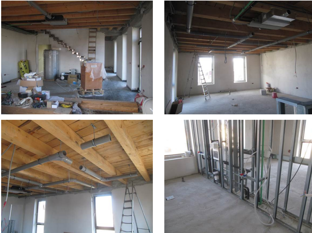
Figura 8 Imagini din timpul execuției finisajelor pentru casa nZEB
