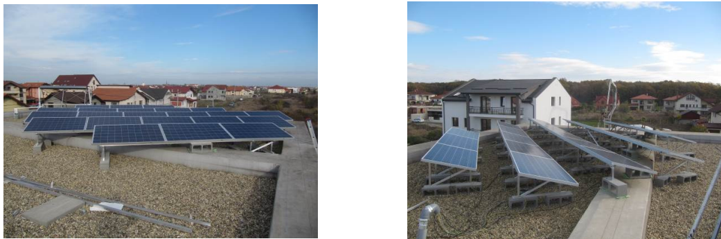
Figura 3.21. Montarea panourilor solare si fotovoltaice pe terasa
