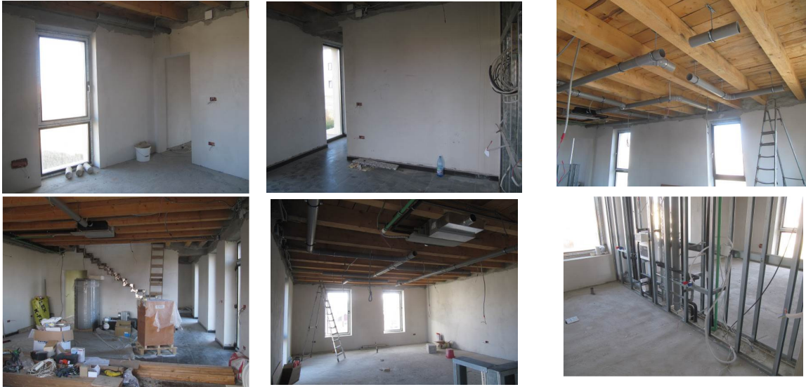
Figura 3.20. Imagini din timpul executiei finisajelor pentru casa nZEB
