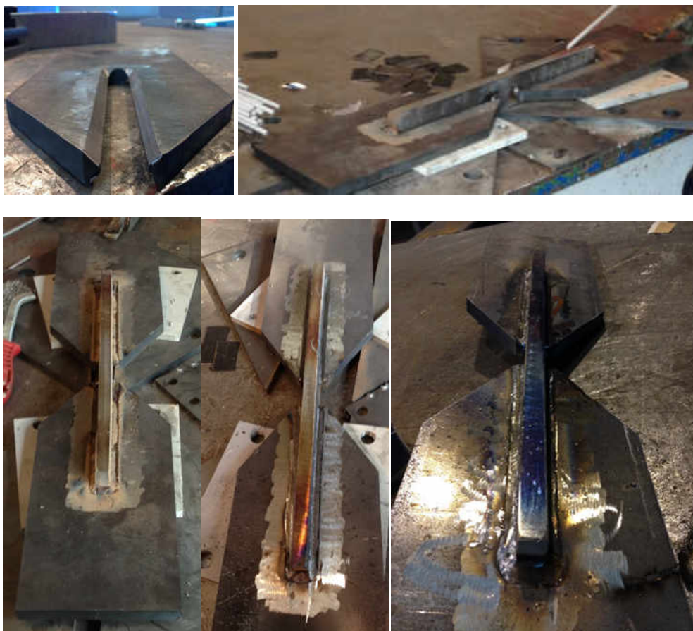
Figura 9. Etape în realizarea sudurii dintre rigidizări și miezul de oțel al BRB: prelucrarea pieselor, centrare, aplicarea strat 1 de sudură, polizare, aplicarea straturilor 2 și 3 de sudură
