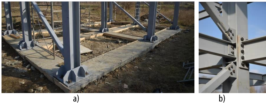
Fig. 18 Vederi din timpul lucrărilor de montaj: a) prinderea stâlpilor în fundații; b) detaliu de nod; c) vedere de ansamblu cu modelul experimental
