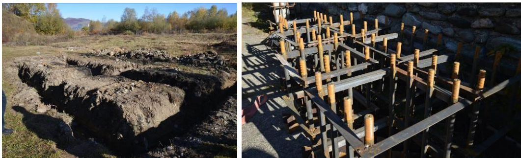
Fig. 17 Vederi din timpul realizării infrastructurii: a) executarea săpăturii pentru grinzile de fundare; b) piesele de ancorare a stâlpilor în grinzile de fundare
