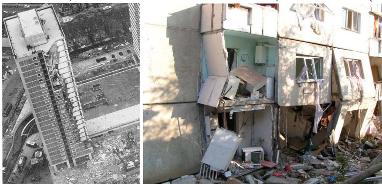
Fig. 1 Explozii de gaze în clădiri: a) clădirea Ronan Point, Londra, 1968; b) bloc de locuințe, Zalău, 2007
