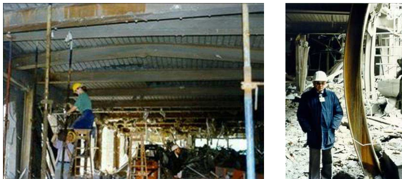
Fig. 2 Exchequer Court, St Mary's Axe, Londra 1992: a) avarii la planșeele compuse; b) avarii majore la stâlpii metalici de la parter
