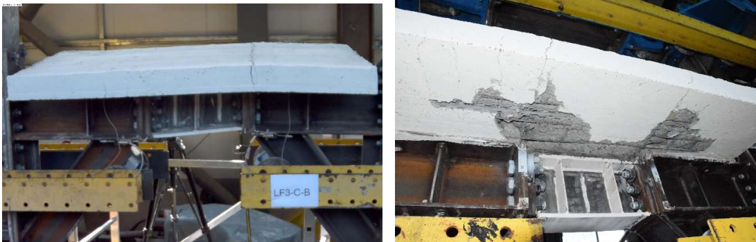
Figura 23. Deformația și starea linkului și a plăcii din beton la sfârșitul încercării LE3-C-B
