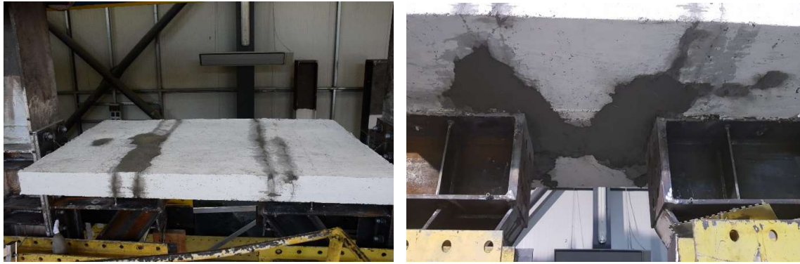
Figura 24. Repararea placii din beton armat
