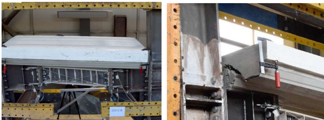
Fig. 11 – Deformația și starea linkului și a plăcii din beton la sfârșitul încercării LE3-C-B
