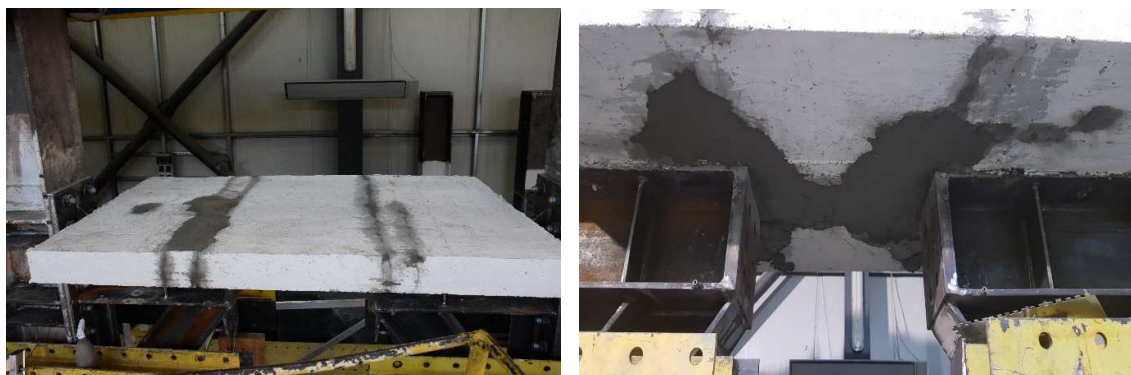
Fig. 16 - Repararea plăcii din beton armat
