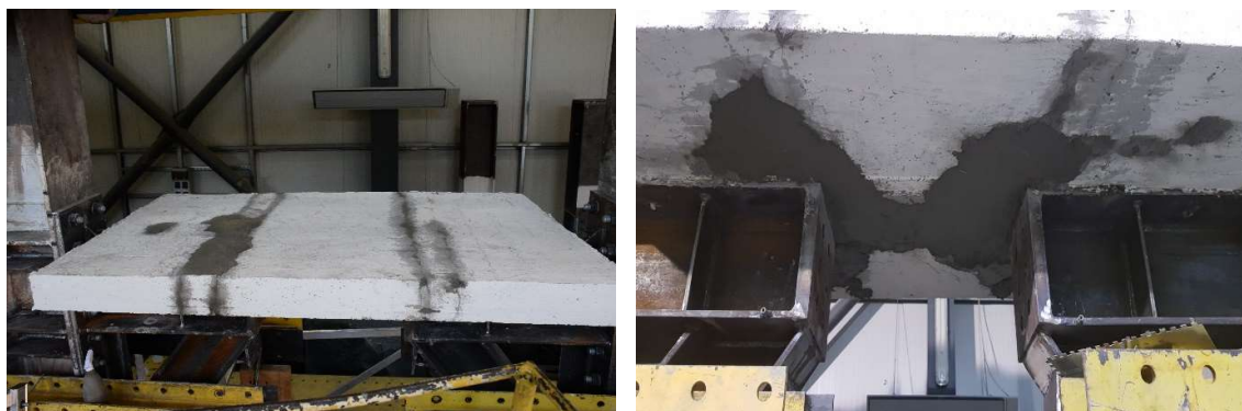
Fig. 24 - Repararea placii din beton armat
