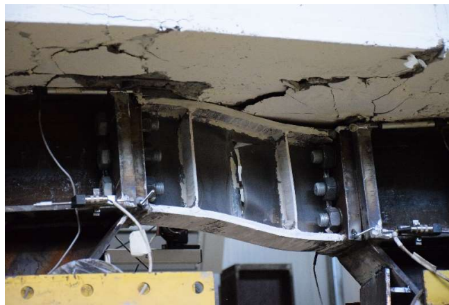
Fig. 28 – Deformația și cedarea și starea linkului la sfârșitul încercării LF4-C-BR
