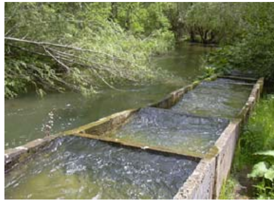
Figure 4. Fish ladder Gura-Golumbului Dam
