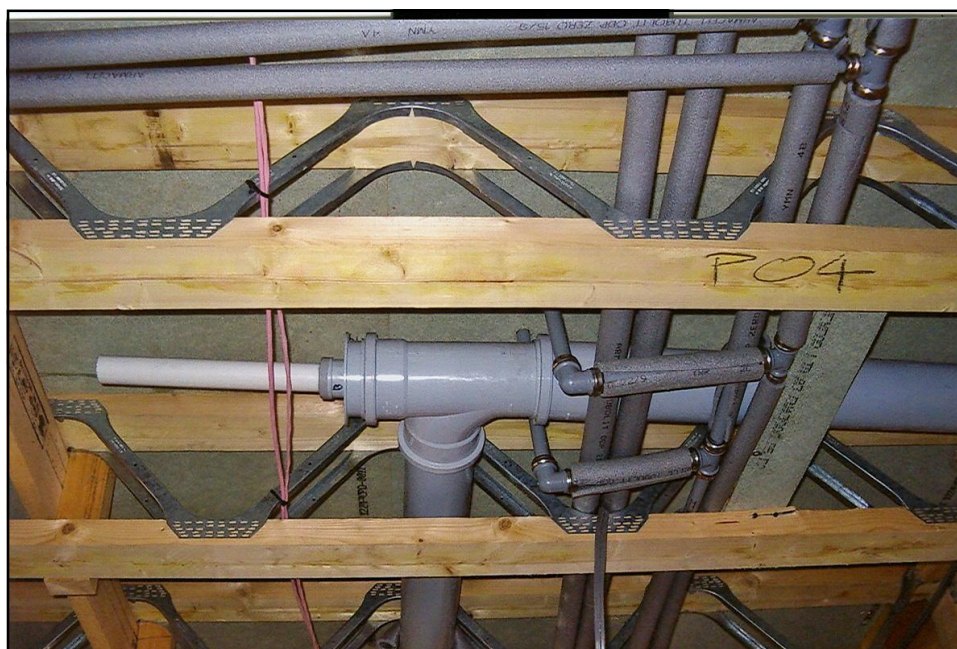
GRINZILE CU ZABRELE DE PLANSEU PERMIT REALIZAREA TUTUROR INSTALATIILOR IN INTERIORUL ACESTORA
