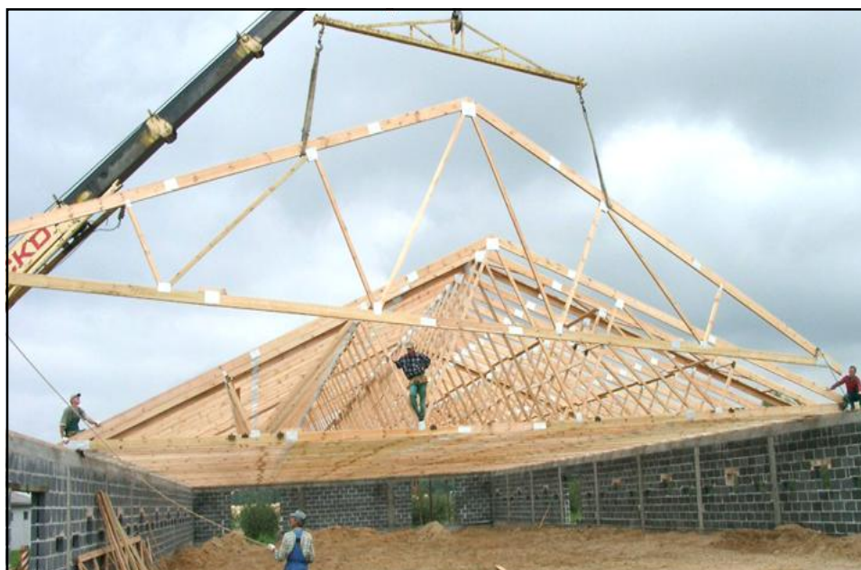
Grinzile cu zabrele asamblate cu placi multicui cea mai economica solutie pentru sarpante cu deschideri mari.
